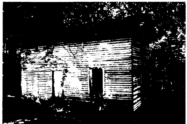
Figure 37. Tenant House II (67-140)
